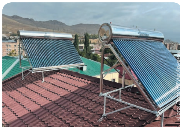
Солнечные водонагреватели на крышах жилых домов в Армении
